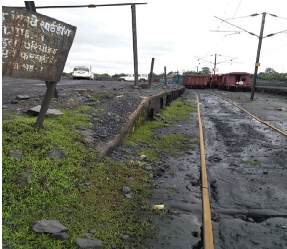
तस्वीर. 03: पैरा नं 4.6.1, तालिका नं 06, क्रम.सं. 04: के जारंगडीह रेलवे साइडिंग सीसीएल के बिना निर्धारित स्पिंकलर के
